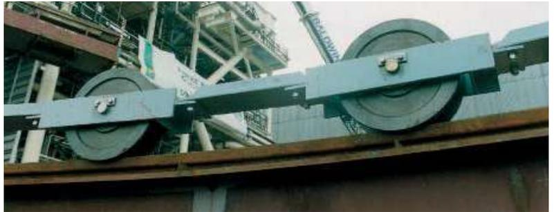
7.600 toneladas y 32 metros de diámetro, girando sobre ruedas de acero de doble pestaña sobre riel, con casquillos autolubricantes. Rueda  $\varnothing 450\text{ mm}$ . y ancho de banda 112 mm.
